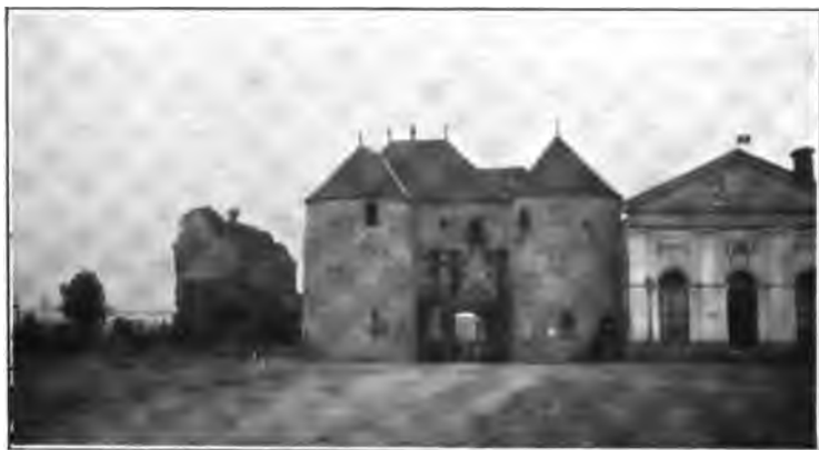
FRESNAY-SUR-SARTHE. — Porte de l'ancien chateau.
